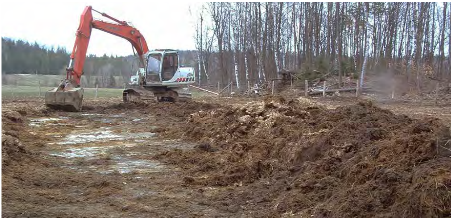
Grattage des fumiers à l'aide d'une pelle mécanique.
