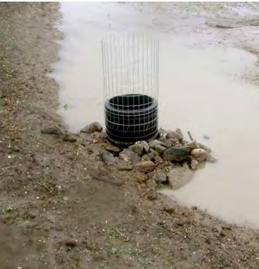
Fossé d'interception en amont de l'enclos et installation d'un avaloir pour capter les eaux du fossé et les faire traverser l'enclos par une conduite d'eau souterraine.
